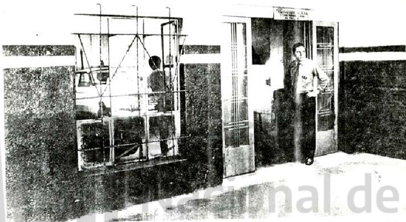
ACCESO AL SECTOR DE TUBOS TOTALMENTE DEMOLIDO
