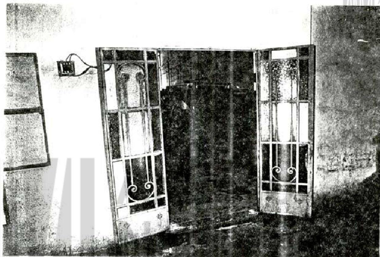
ENTRADA SECTOR DETENIDOS - COCINA - COMEDOR Y 52 OFICINAS - AMBAS FOTOS - COMO ASI TAMBIEN AL QUIROFANO - BAÑOS Y DUCHAS - OFICINA GT2
