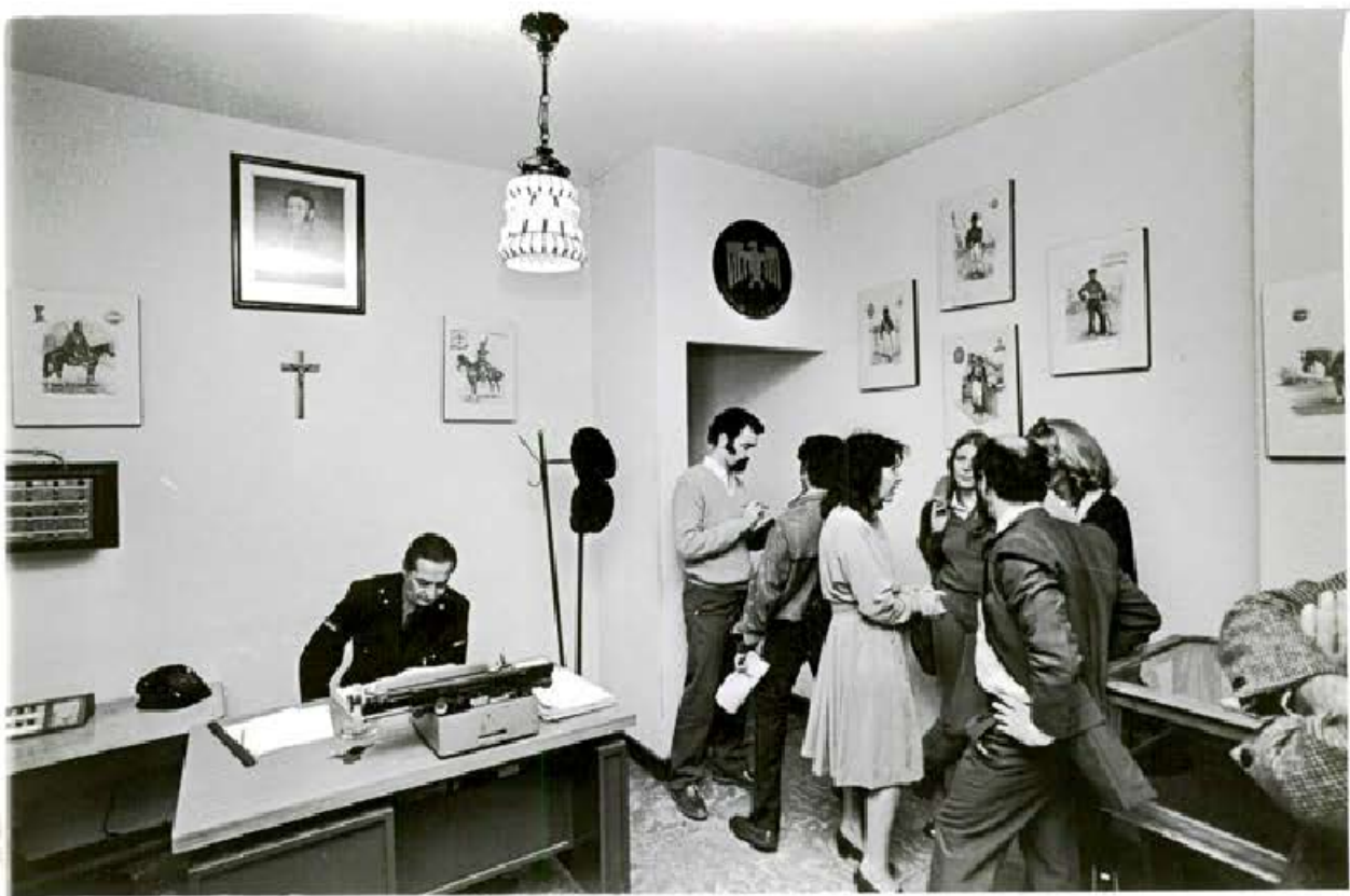
6-4-84 - Oficina de la V.B. por lo que se sale al garage. Inmediatamente reconocido el sellano y puerta. En el exterior ha sido modificada.
