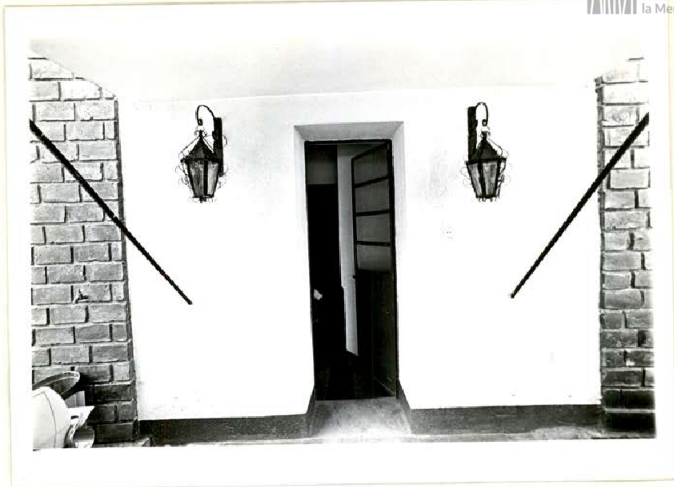
6-4-84- Exterior de la salida al garaje: ha sido modificado.
